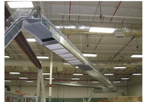
Le système de convoyeur d'air filtré de 24" suspendu au plafond libère de l'espace au sol.
